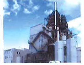
岩国バイオマス発電所
